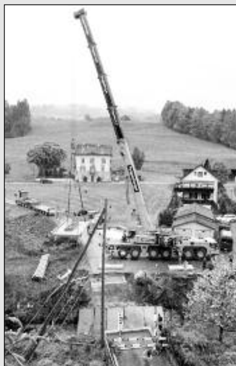
Neue Brücke im Jonatal: 50 Tonnen Beton schwebten an Stahlseilen durch die Luft. (Foto: ü)
