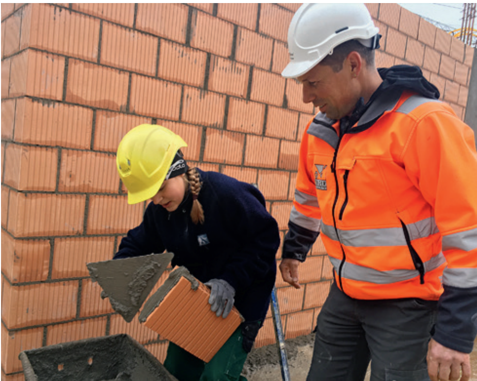
Lena mit Markus Stalder auf der Baustelle: Kraft, Koordination und Handgeschick sind gefragt. (Fotos: Irene Lang)
