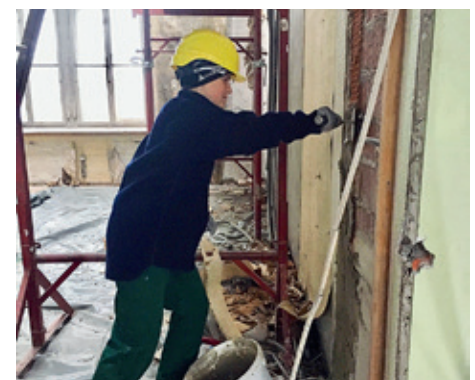
Brandschutz: Balken mit Feuerschutz behandeln.
