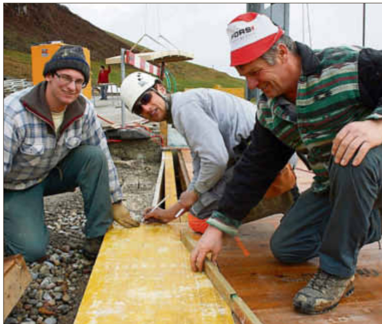
Reto Litschi, Polier Marco Delle Cave und Markus Litschi auf der Baustelle im Ghöch. Bild: Patrizia Legnini
